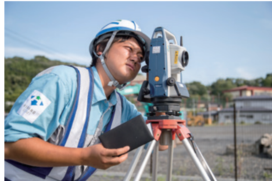
現在は一関市の下水道工事の現場で測量などを担当。
