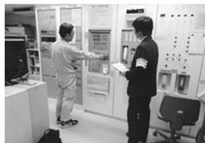
保守点検を行う組合員所属の消防設備士と現場検査を行う共同受注検査員
