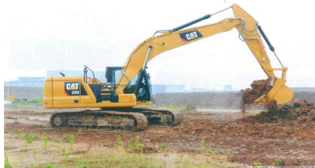
【導入した ICT 油圧ショベル】
