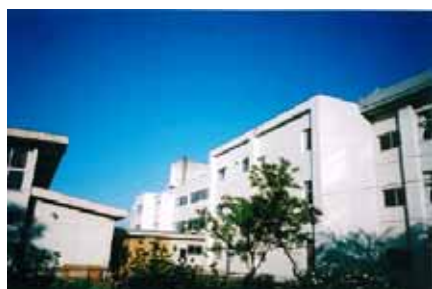
盛岡市立月が丘小学校外壁改修工事 (スーパーピンネット工法)
