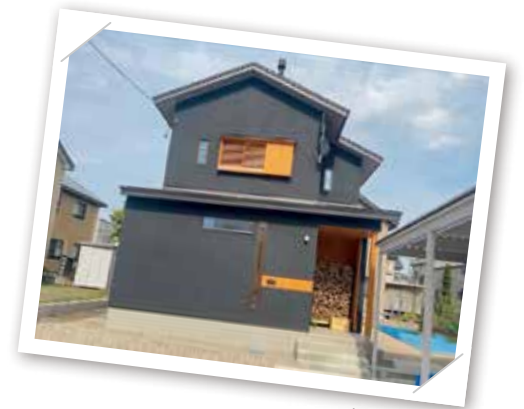
施工事例外観
