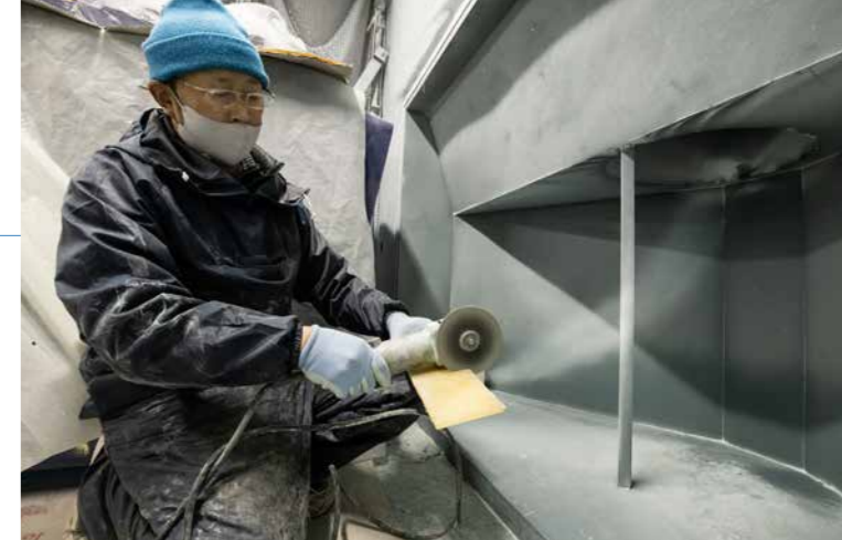
トリミング作業時に使用する集塵機。バリを切り落とす際に出る微細な粉塵を瞬時に吸い取っていく。
