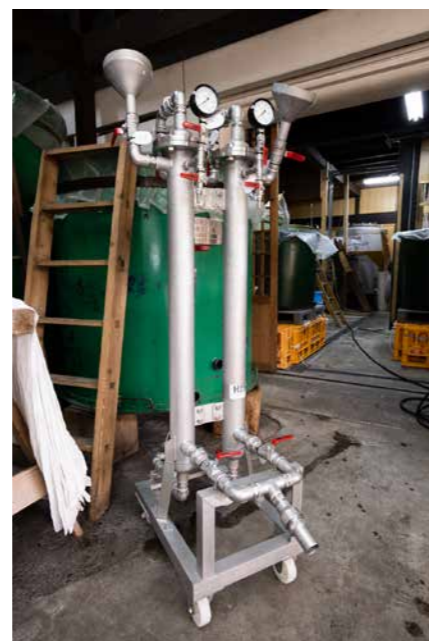
今回導入した中空糸式ろ過機。パイプの中に中空糸膜SFフィルターが入っており、下部のバルブから入り、上部に向かって酒が吸い込まれ、ろ過される。
