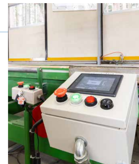
型枠の設計図データはUSBに入れ、自動型枠機に差し込むとデータが読み込まれその通りの型枠が制作できる。
