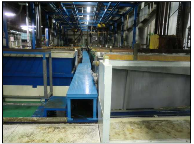
亜鉛めっき処理設備
