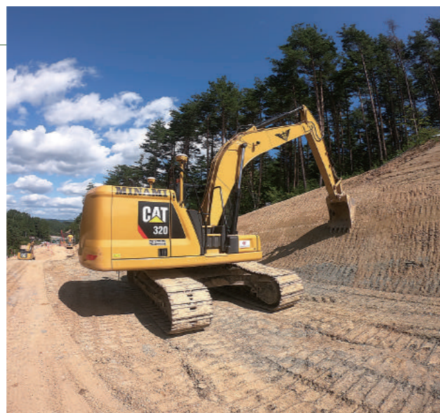
本事業で導入した、キャタピラー製、情報化施工の油圧ショベル。ICT機器と組み合わせ使用している。
