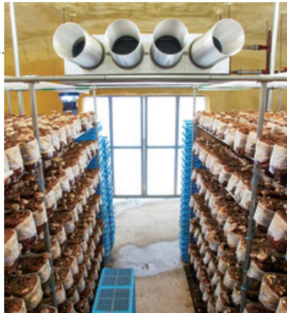
空冷ヒートポンプチラーから作られる冷水から供給される冷氣により、栽培ハウス内の温度を調節している。
