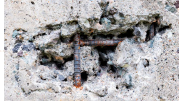
「トレーラーウォータージェット」により除去されたコンクリートの劣化部。健全なコンクリートや鉄筋を傷つけずに除去することが可能となった。
