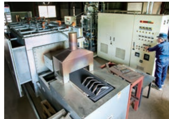
本事業で新たに導入した連続式焼成炉と発熱型プロパンガス変成炉。
