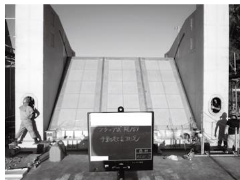
フラップゲート式防潮堤 起立時
