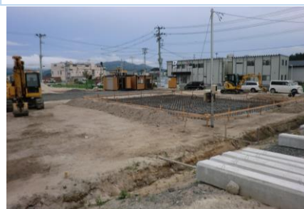
工事が進む建設予定地
