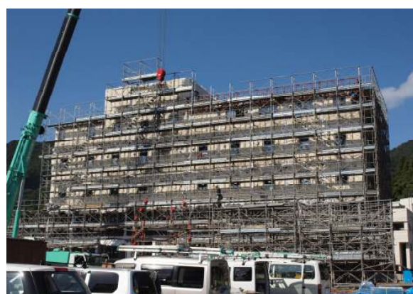
釜石市を皮切りに沿岸地区で10棟建設予定の宿泊施設
