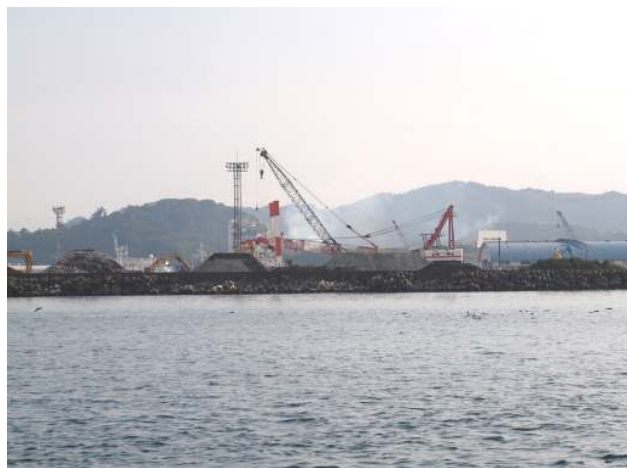
港湾工事の様子（宮古港）
