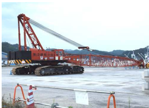
大型の重機が稼働している
