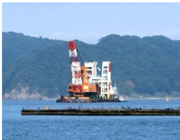
生コン不足の打開策として導入されたミキサー船 海上で生コンクリートを製造し、打設作業もこなす。 ただし、従来方式に比べコストは割高となっている。
